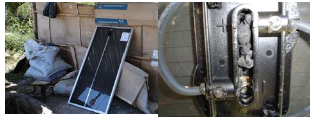
Fig.7 Fotografía original del módulo FV que presento falla en el sistema FV de El Laurel , durante la prueba de aceptación y el cual fue reemplazo haciendo válida la garantía.
